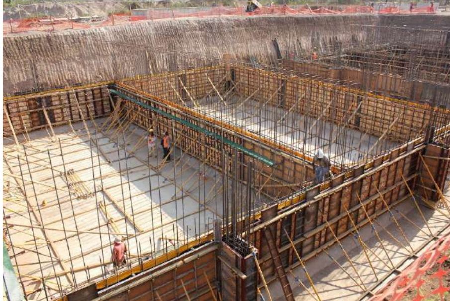
Figura 15. Construcción del reactor UASB de la PTAR de Granada, Nicaragua
