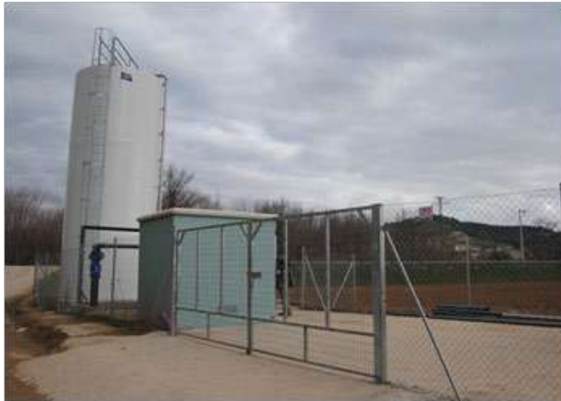
Figura 21 PTAR con elevado impacto visual
