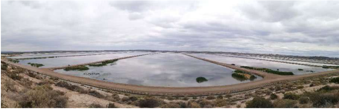
Figura II.3. Planta de tratamiento con lagunaje en Mendoza, Argentina
