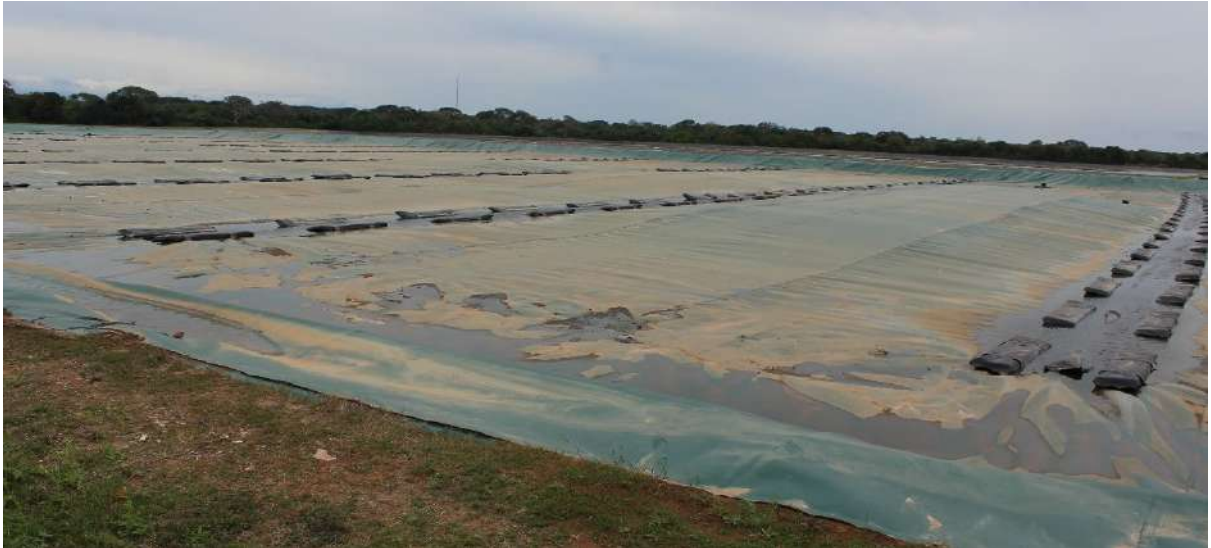
Figura 20 Lagunas anaerobias cubiertas (Santa Cruz, Bolivia)
