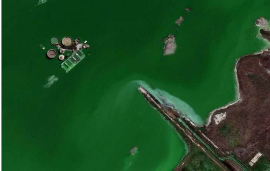
Figura 1.3. Imagen de PTAR construida en zona inundable (Google Earth)
