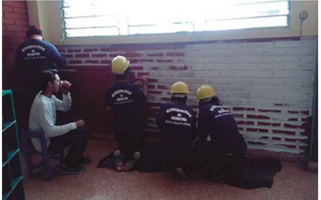
Pintura de muros interiores de ladrillo visto
