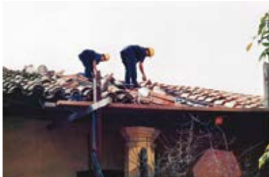
Trabajos de albañilería Restauración de puertas y ventanas
