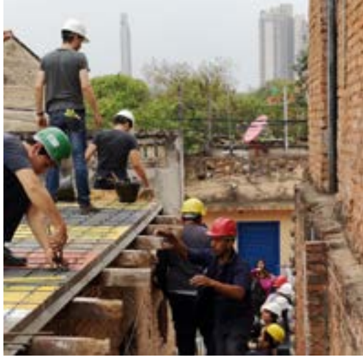
Preparación de armadura para el vaciado de a cubierta
