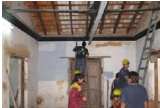
Desmontaje de cielorraso para intervención
