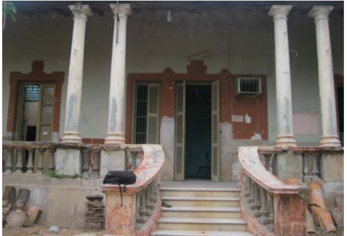
Vista de zona antigua, previa a la intervención
