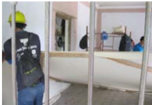
Desmontaje de elementos adicionales en interiores
