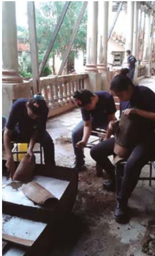
Proceso de limpieza de las tejas para su reposición en la cubierta
