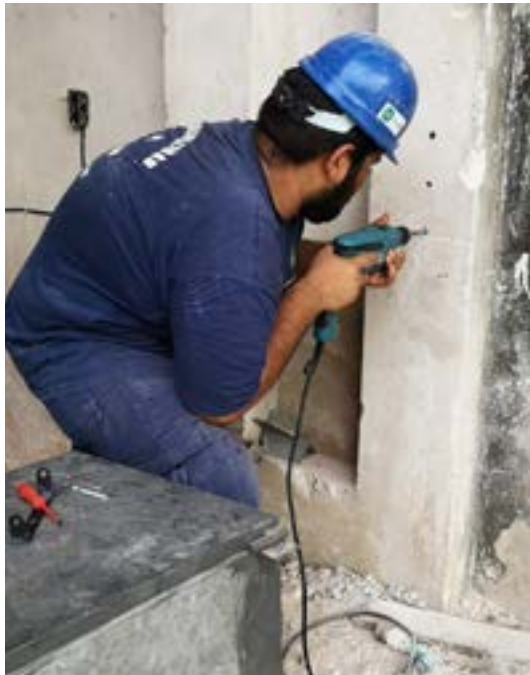
Ejecución de instalaciones Recolocación de pisos originales
