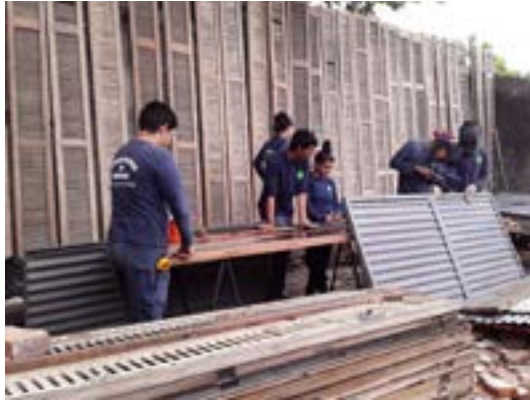
Reparación de puertas metálicas
