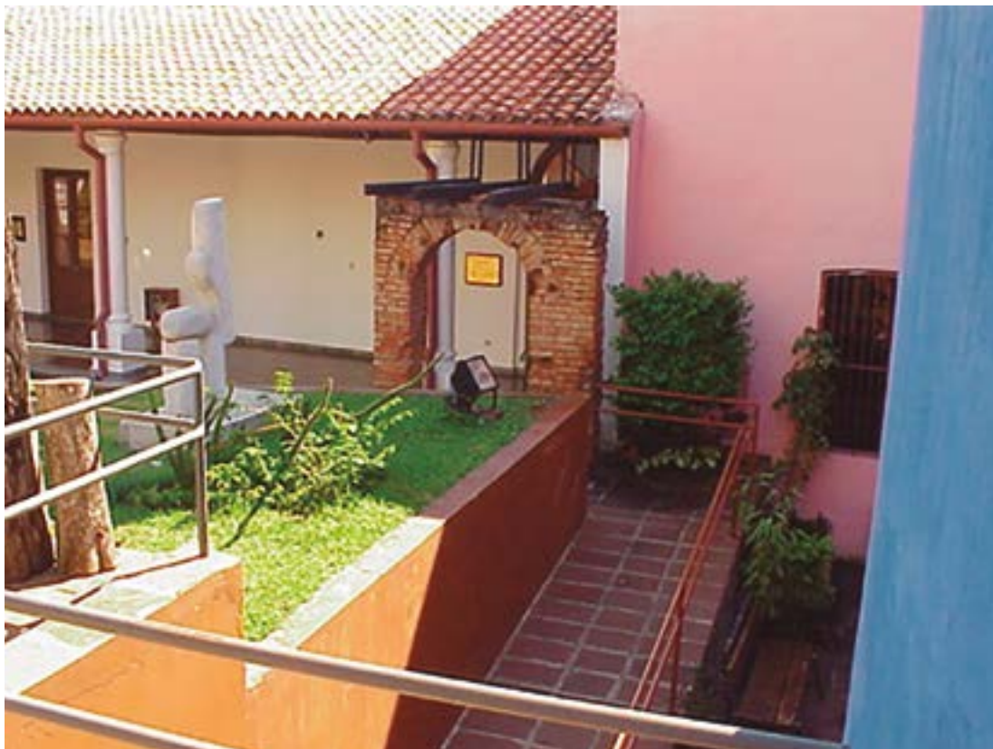
Patio Leonor. Lado izquierdo finalizado
