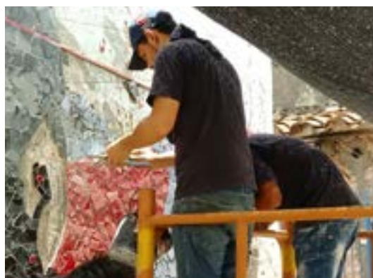
Ejecución de mosaico gigante en muro exterior Preparación de material para aplicación de mosaicos
