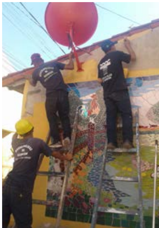
Resane de muros exteriores Ejecución de mosaico en muro bajo
