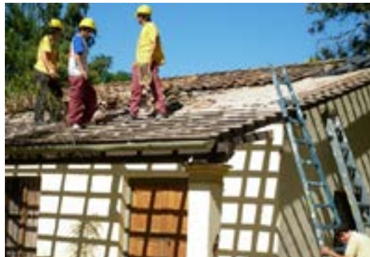
Proceso de destechado para iniciar la restauración
