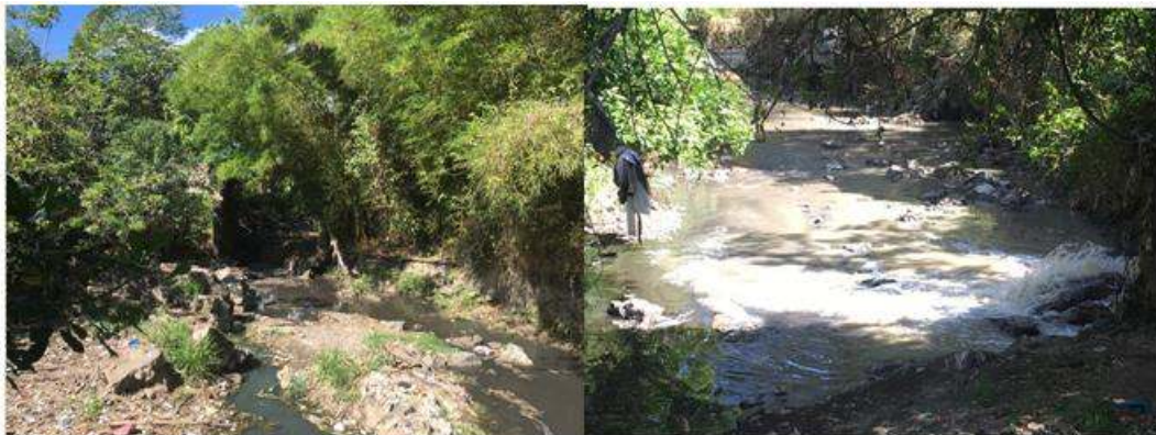
Punto de Descarga del Colector Santa Ana
