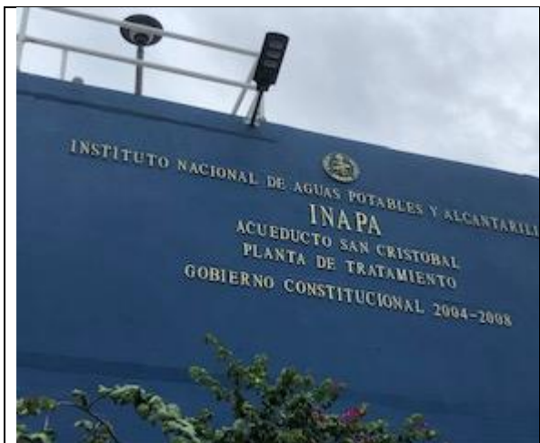
Entrada Planta de Potabilización
