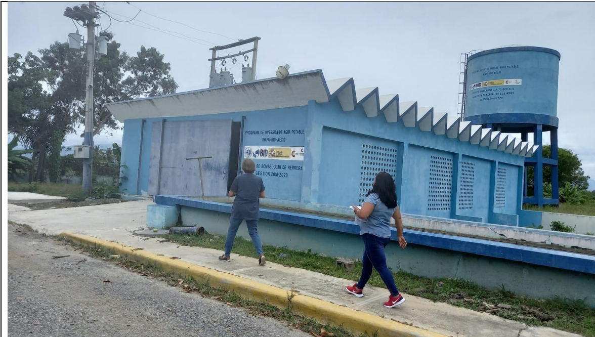
Estación de Bombeo Planta Nueva
