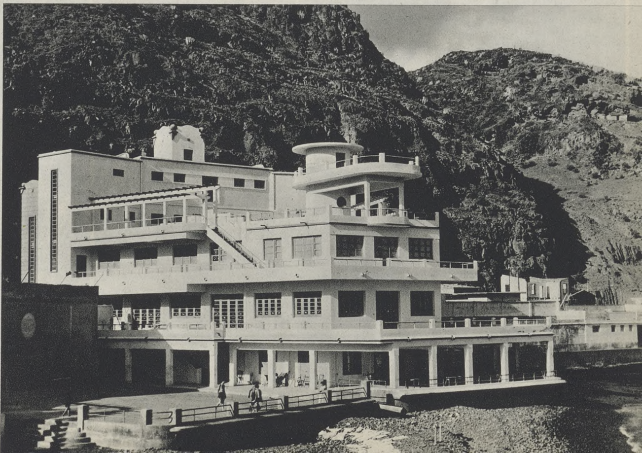
A la orilla misma del mar hay también ya varias residencias construidas, como esta familiar en Santa Cruz de Tenerife, en un magnífico paraje.
