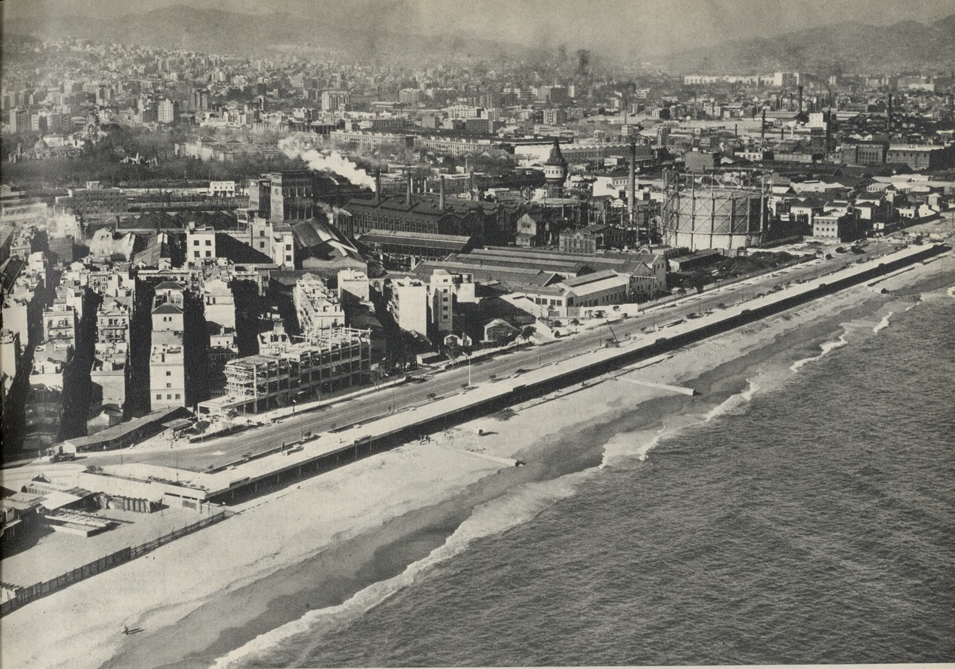
El Paseo Marítimo, visto desde el mar. La escuela en construcción, en primer término.
