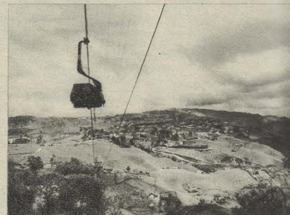
«El Cable» sirve de medio de transporte para salvar las diferencias de altitud del complejo urbano con los alrededores.
