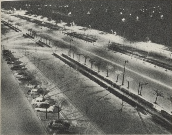
18 DE ENERO. —LUCES DE MADRID. El Ministerio de Obras Públicas ha instalado en la avenida del Generalísimo una excelente iluminación, que compite ventajosamente con la de las más afamadas capitales del mundo. He aquí una bellísima perspectiva.
