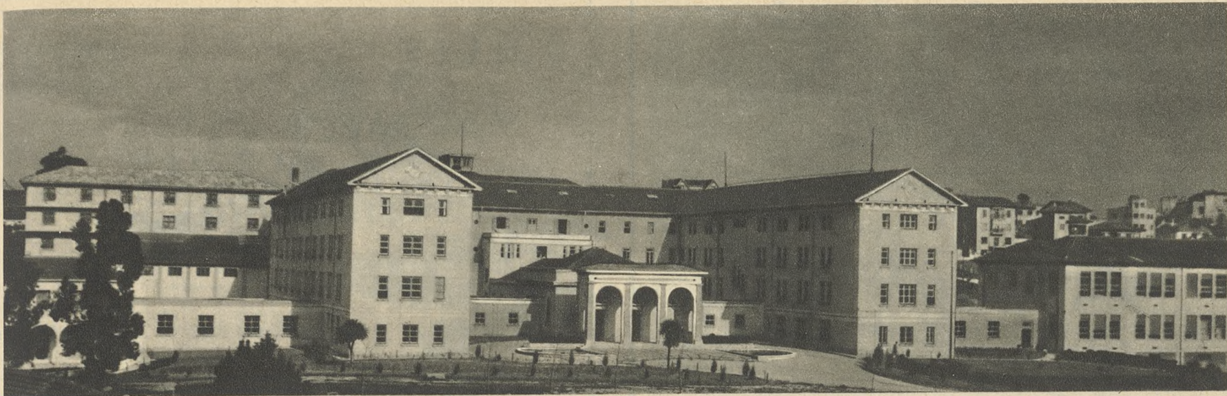
El Hogar Provincial Cántabro, magnífica realización de la Diputación provincial de Santander. En su bella fachada queda sintetizada la moderna arquitectura de la Montaña.
