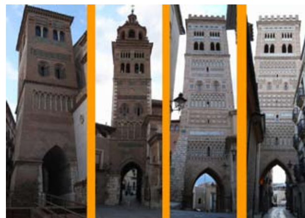
Intervención en la muralla Torres mudéjares
