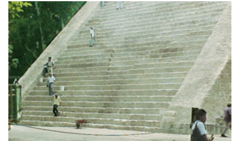
Vista parcial de la fachada frontal del Templo V. Trabajos de integración cromática con una mezcla de mortero de cal y tierras locales, que permiten el rápido crecimiento de microflora, necesaria para la protección y transpiración propia del edificio.
