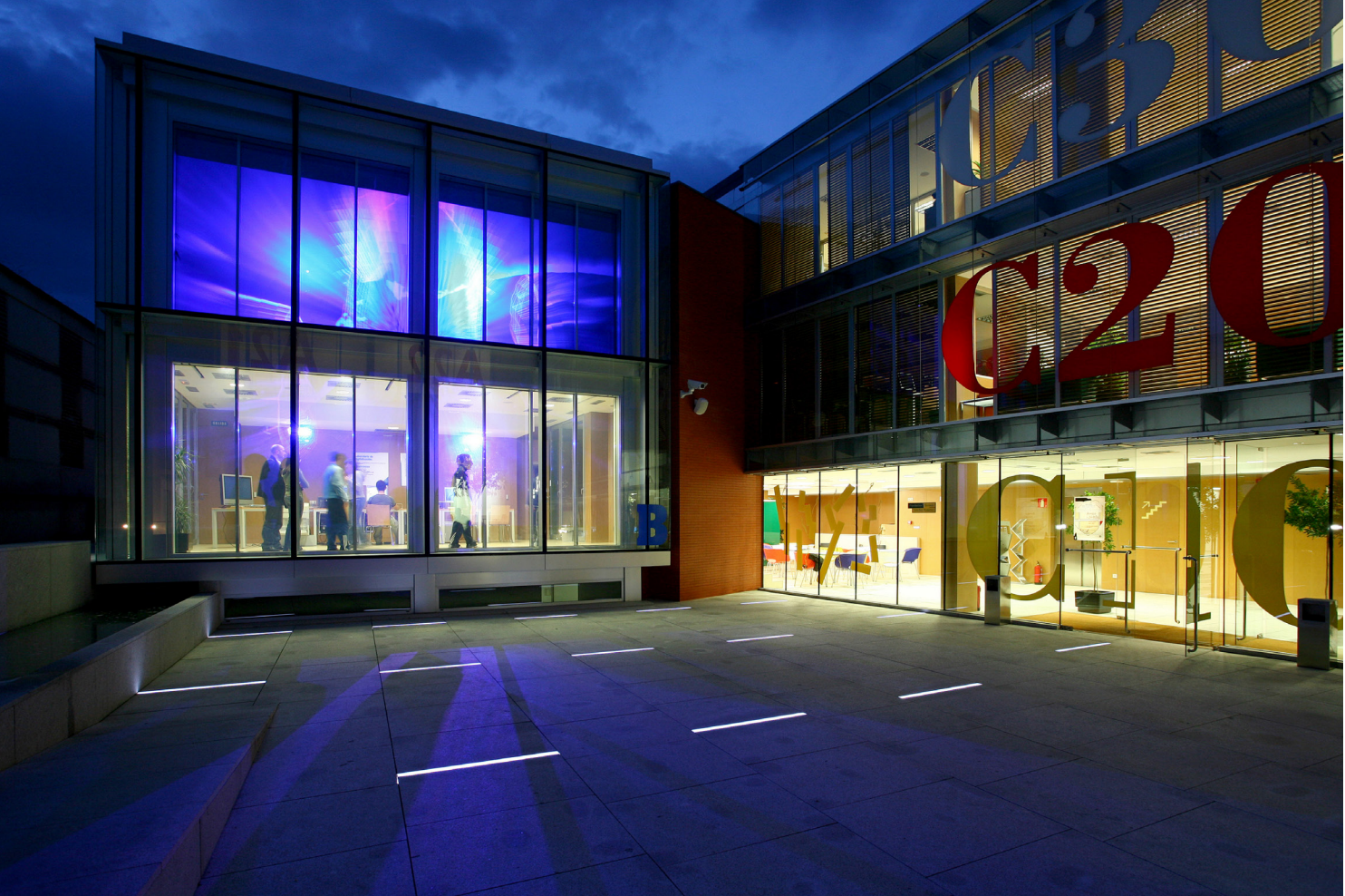
CITA , Peñaranda de Bracamonte, Salamanca. Hernández León Arquitectos/Siza/A. Corazón.
