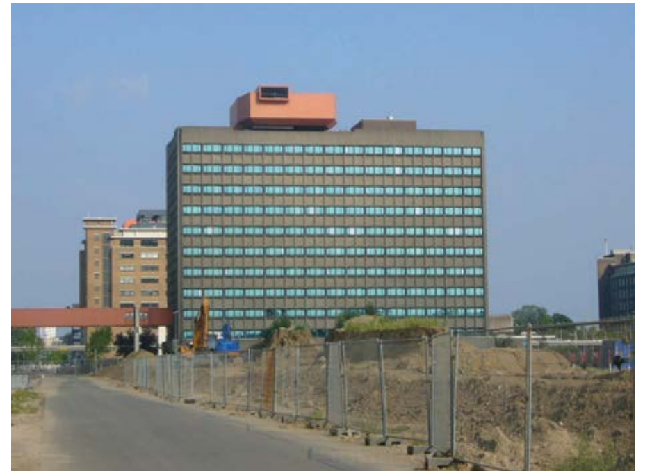
Demolición del edificio SFF / Demolition of Building SFF / Strijp-S, Eindhoven, 2009
