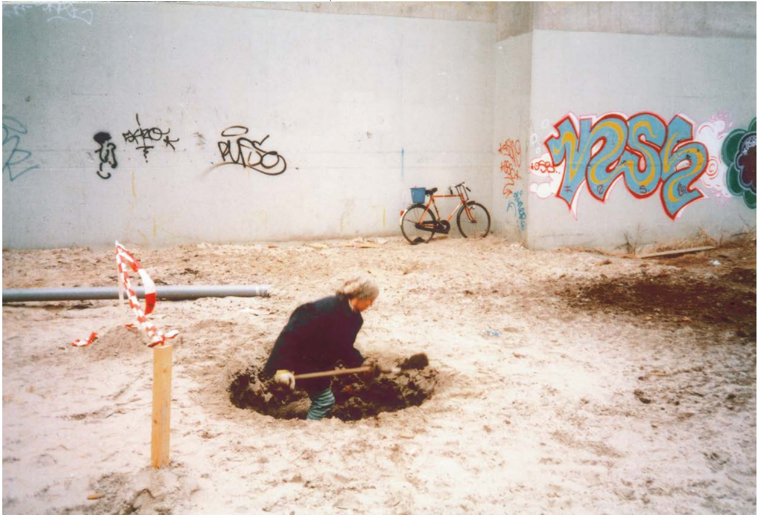
Excavación / Digging / Ámsterdam, 1998
