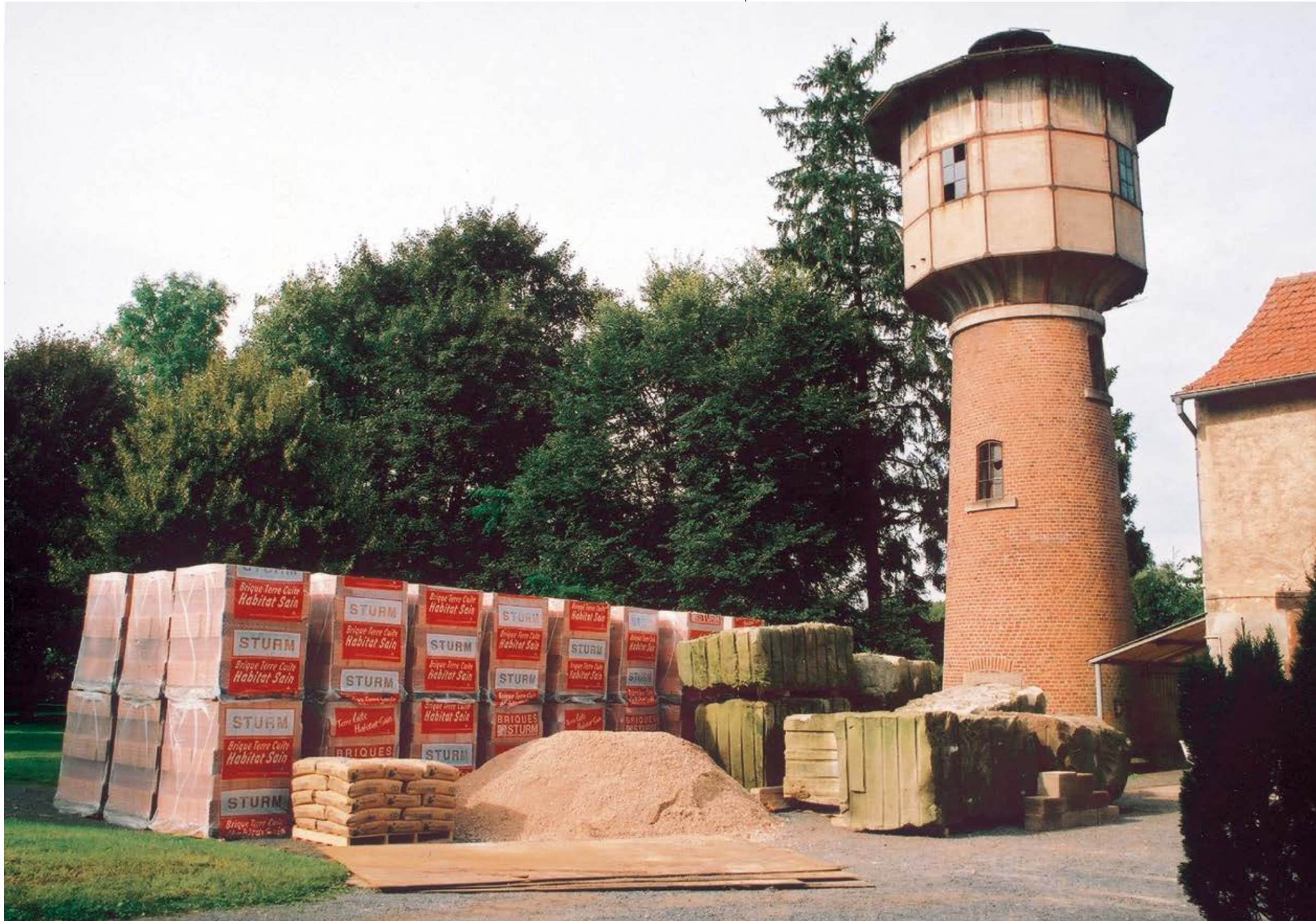
Materiales de construcción, torre de agua / Construction materials, water tower / Phalsbourg, 2000
