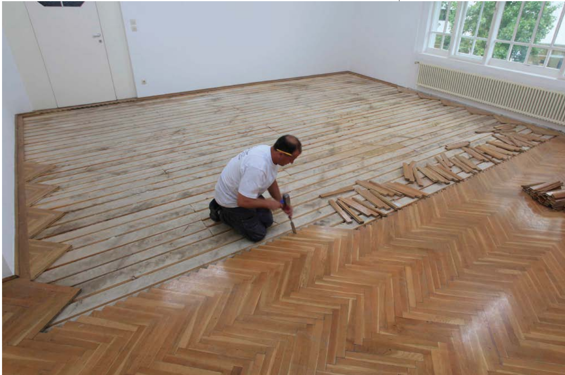
Quitando el suelo de parquet / Removal of the wooden floor / Grafisches Kabinett, Secession, Viena, 2010
