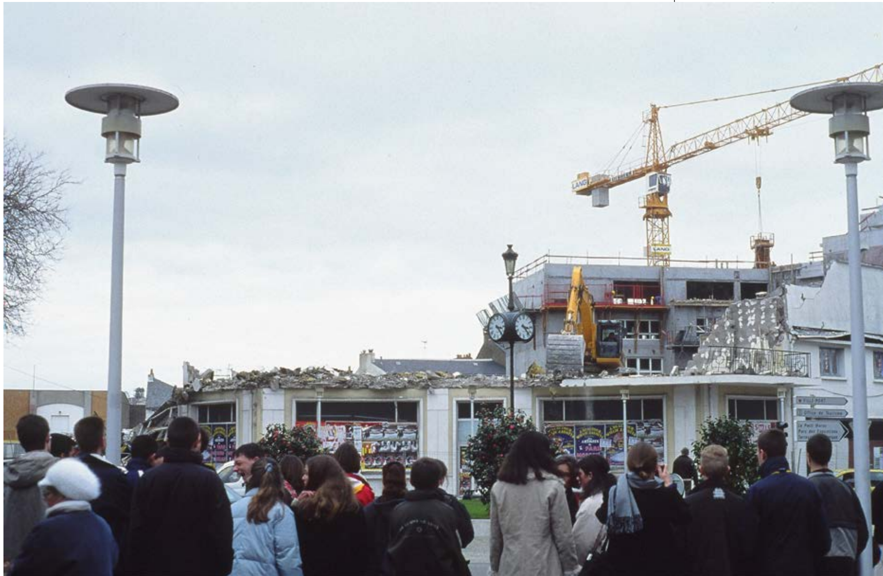
Demolición frente al centro de arte contemporáneo Le Grand Café / Demolition in front of Le Grand Café contemporary art centre / Saint-Nazaire, 2002
