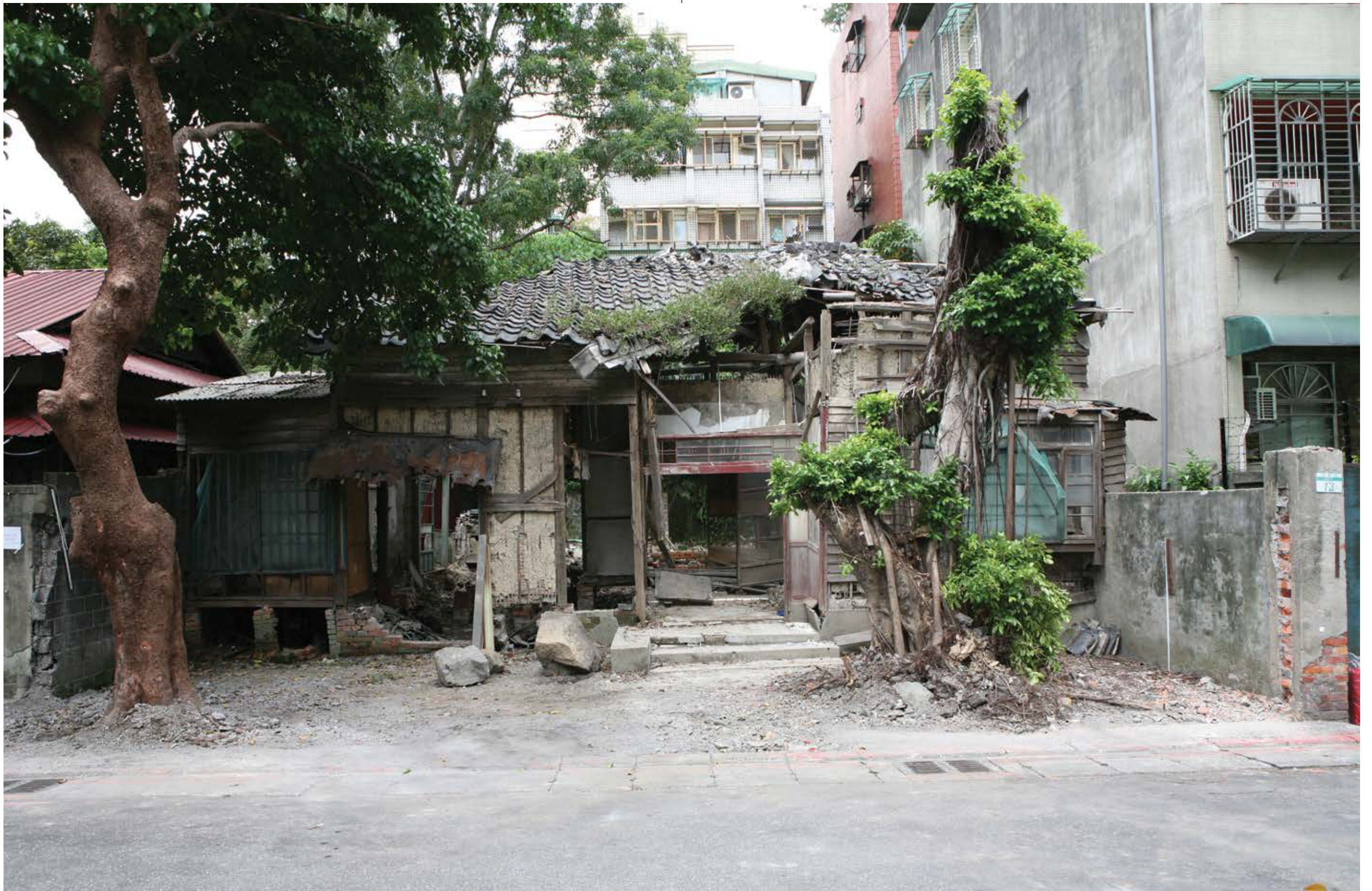
Retirada del muro exterior de una casa en ruinas / Removing the outside wall of a ruined house / Taipéi, 2008
