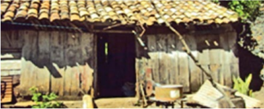
Estado de cubierta y paredes
