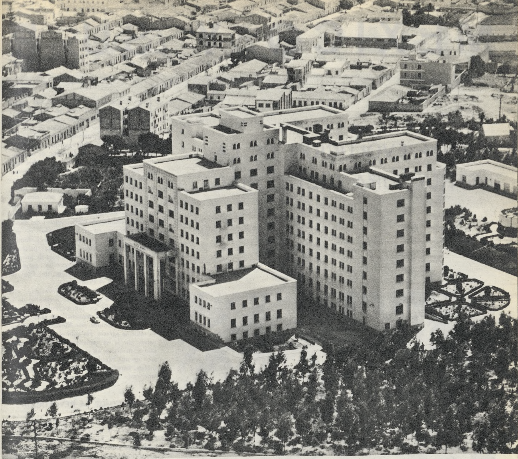
Residencia sanitaria de Alicante
