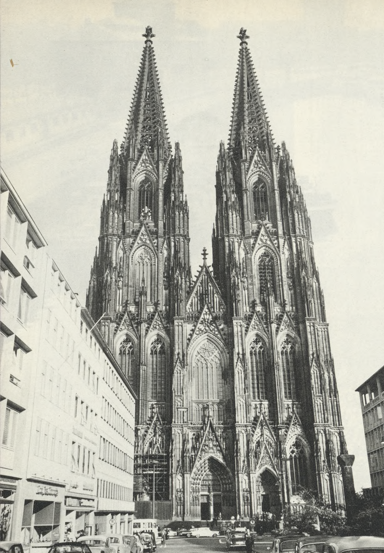
La fachada oeste de la magnífica catedral eleva su arrogante arquitectura. Esta fachada tiene cinco pórticos, que corresponden a las naves interiores.
