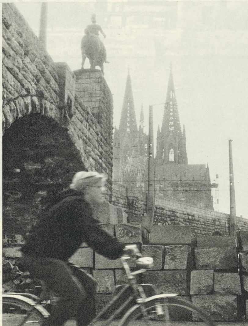
El puente de Hohenzollern, que, como todos los del Rin, fue destruido durante la guerra y sustituido por otro metálico, conservando los pilares antiguos.
