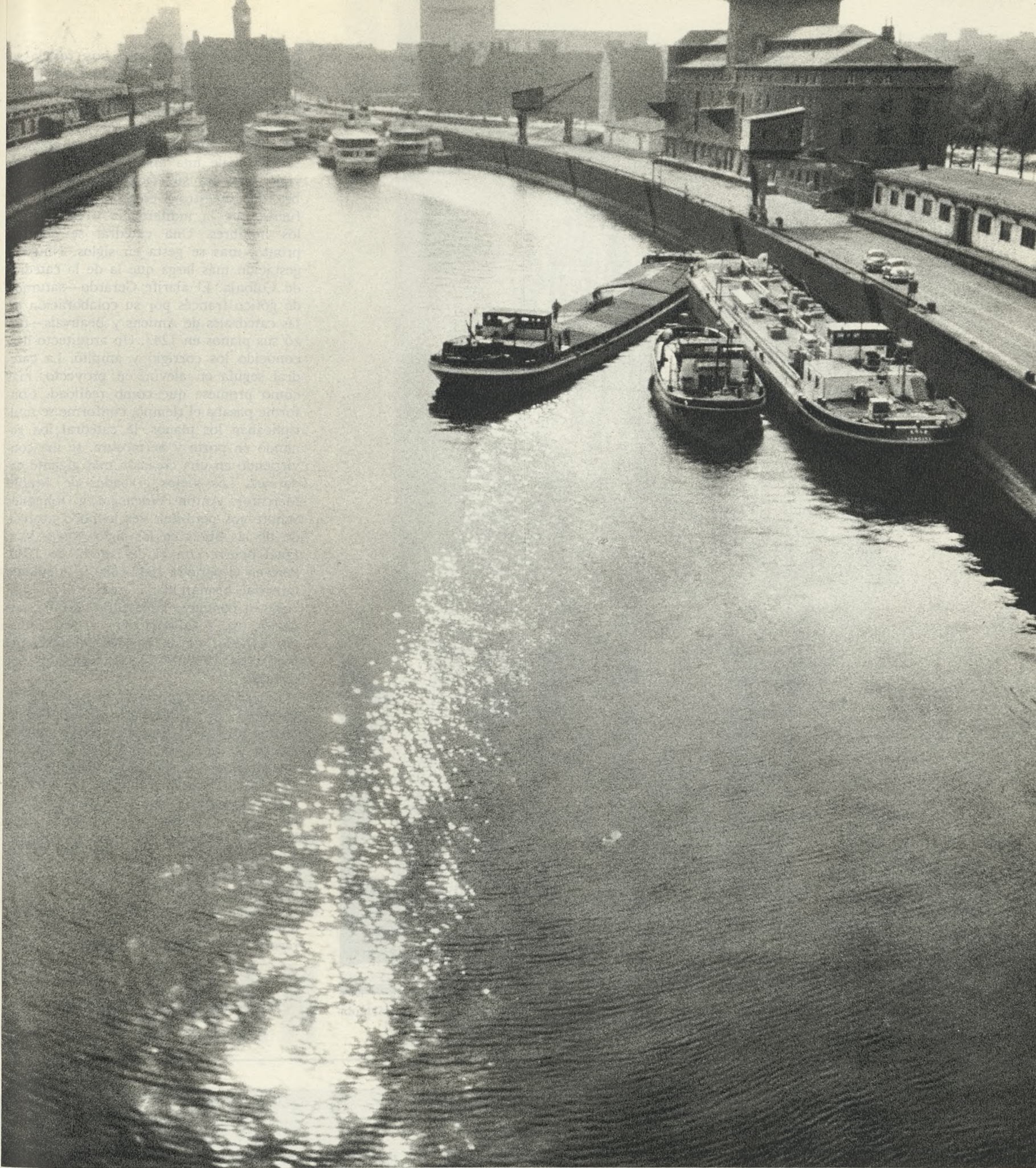
El muelle apunta su destino fabril sobre las plateadas aguas. A todo lo largo pueden verse los tinglados que hacen activo y utilitario el puerto fluvial.
