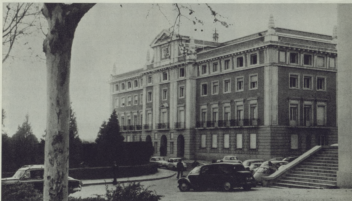
Edificio del Instituto de Cultura Hispánica de Madrid.
