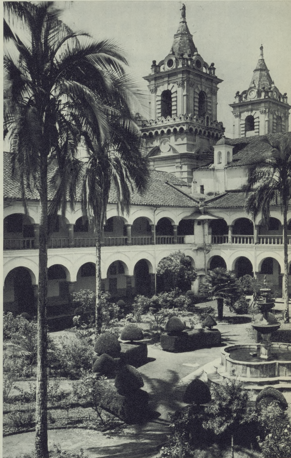
Sobre el patio del convento, las torres del gran templo de San Francisco.
