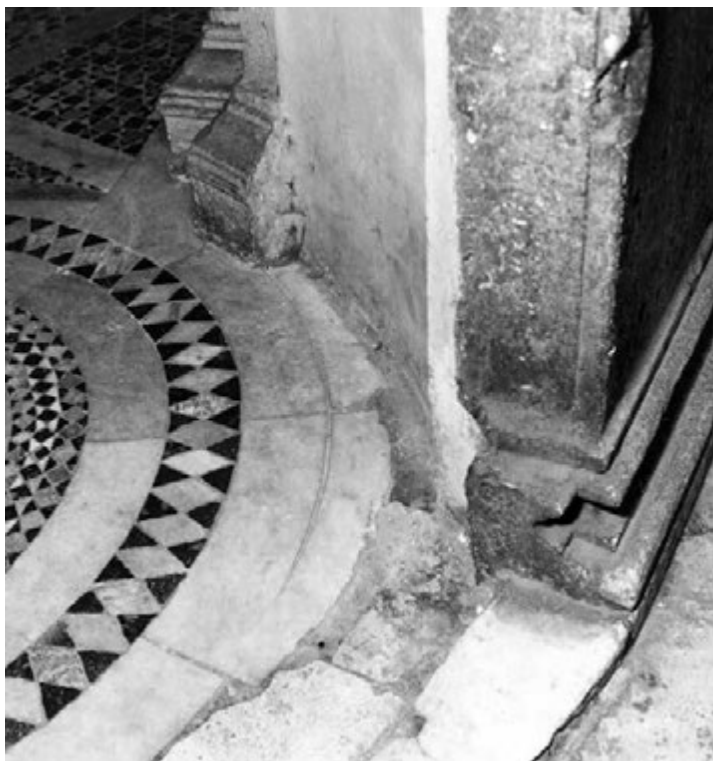
Fig. 3. Ingresso laterale sud: la lastra all'estremità del pavimento presenta un cerchio inciso e un bordo irregolare che prosegue sotto il profilo dello zoccolo. Il profilo attico dello zoccolo nello spessore della porta appare interrotto. Ciò significa che in origine non erano previste porte laterali; sopra lo zoccolo furono apportati cambiamenti al progetto asportando i profili già messi in opera in corrispondenza delle porte laterali attuali (foto Bibliotheca Hertziana)
