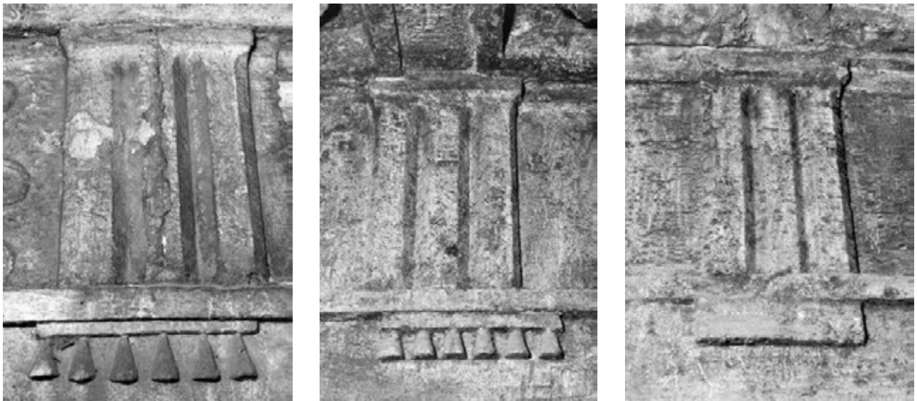
Fig. 15. Particolari dei triglifi e delle regulae : a, del fregio esterno della peristasi; b, c del fregio esterno della cella. Si evidenziano notevoli irregolarità e l'esecuzione è poco precisa (foto Bibliotheca Hertziana)
