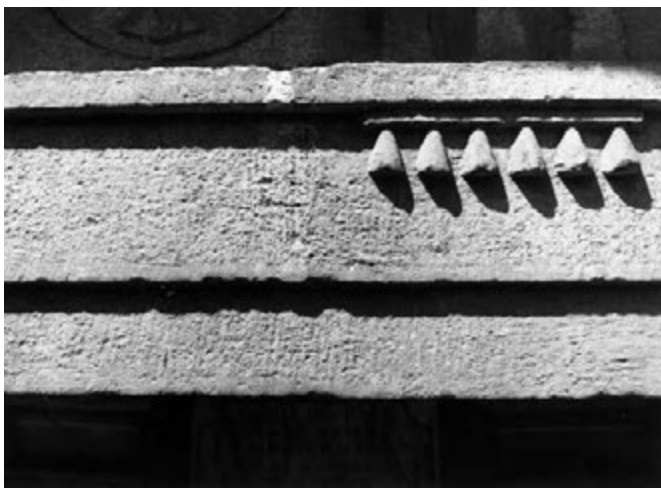
Fig. 16. Lavorazione delle superfici: bordi dei concii scalpellati e trattamento con la gradina (foto Bibliotheca Hertziana)
