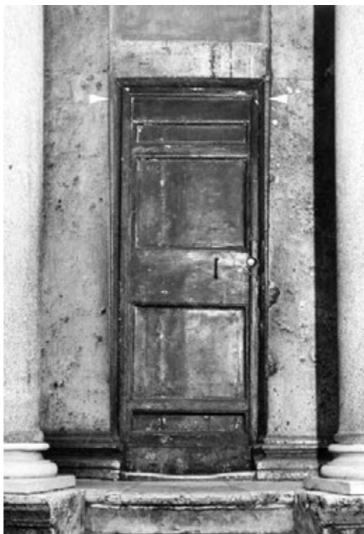
Fig. 4. Porta laterale sud. Le paraste rastremate verso l'alto dell'ordine dorico della cella costituiscono al contempo l'imbotte della porta. Dopo il cambiamento del progetto, sopra il profilo dello zoccolo sono stati aggiunti ai lati delle paraste i montanti verticali sui quali poggia l'architrave della porta (foto Bibliotheca Hertziana)
