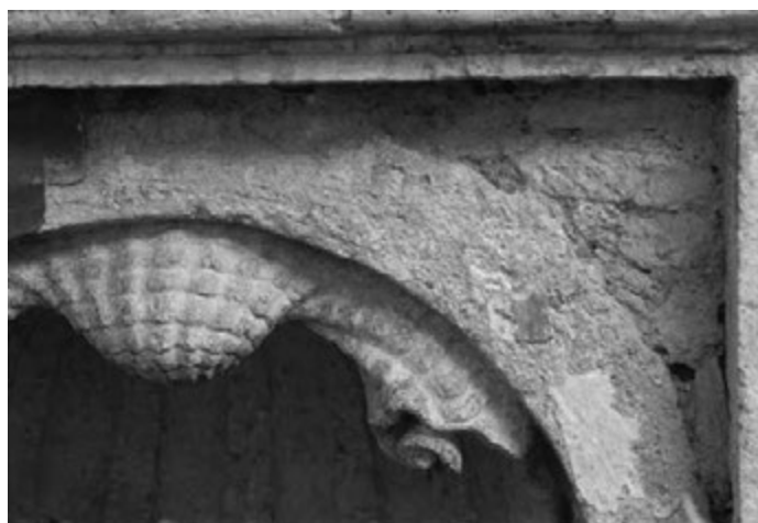
Fig. 20. Saggi stratigrafici in corrispondenza del punto di giunzione tra travertino e intonaco nelle nicchie esterne della cella
