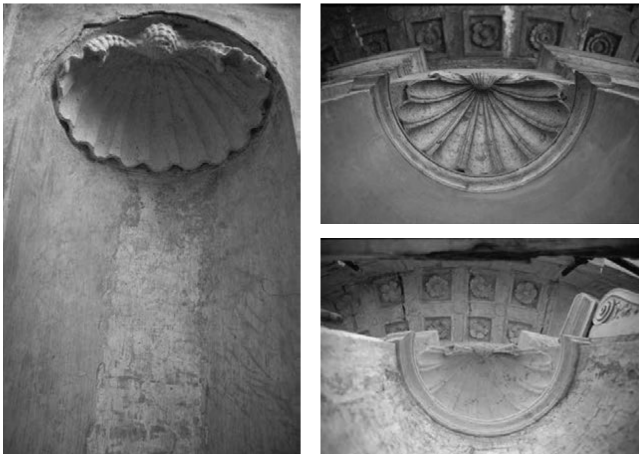
Fig. 23. Intonaco di Valadier in una nicchia del tamburo
