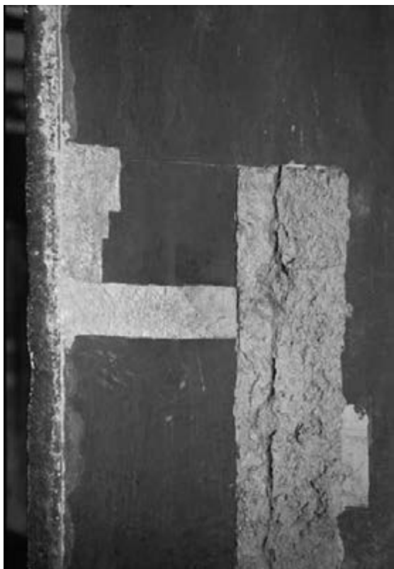
Fig. 20. Saggi stratigrafici in corrispondenza del punto di giunzione tra travertino e intonaco nelle nicchie esterne della cella
