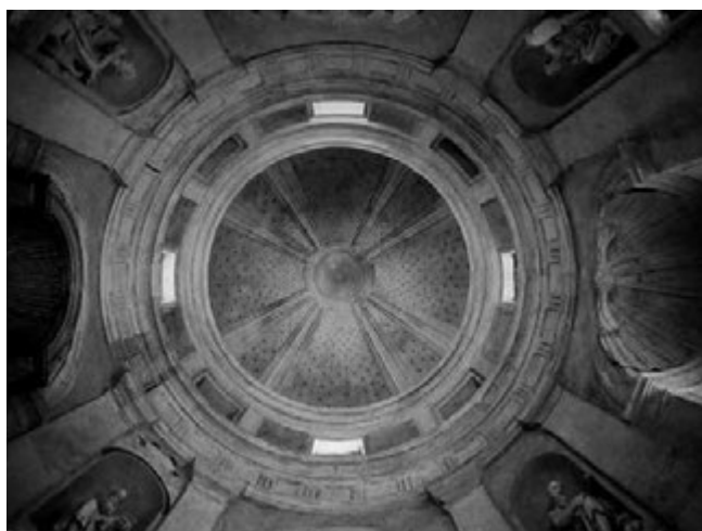
Fig. 7. La bóveda con el cielo estrellado tras la restauración
