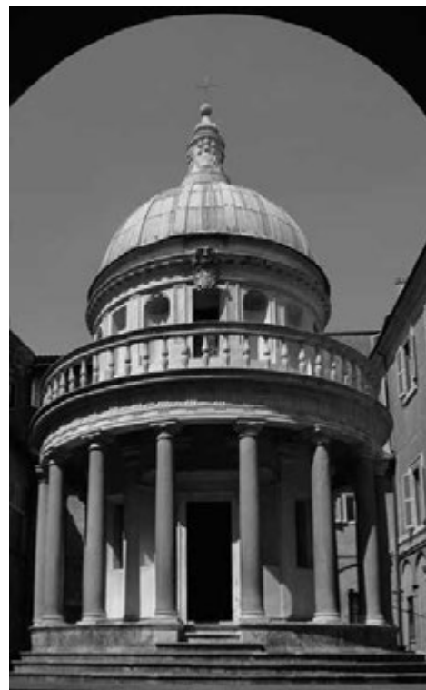
Fig. 1. El Templete una vez finalizada la restauración
