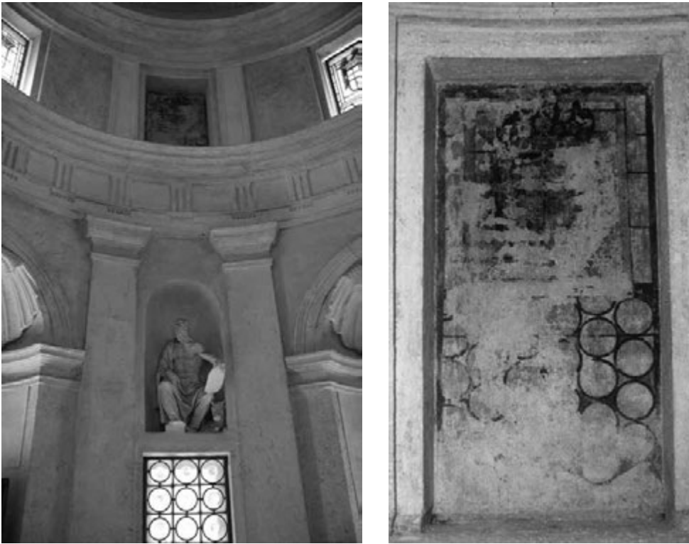
Fig. 5. Detalle del interior de la capilla tras la restauración. Escultura de San Lucas y, en el tambor, restos de policromía Fig. 6. Escudo pintado en una de las ventanas ciegas del tambor, situado sobre la hornacina de San Lucas, ya restaurado
