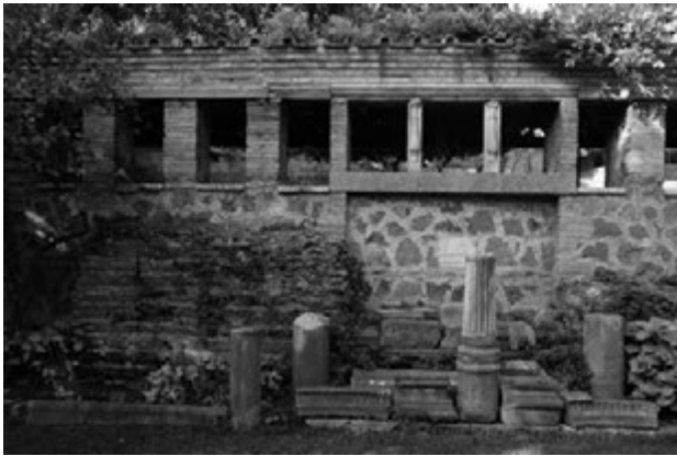
Fig. 18. Giardino del convento di San Pietro in Montorio, muro in opera listata (foto G. Schingo)
