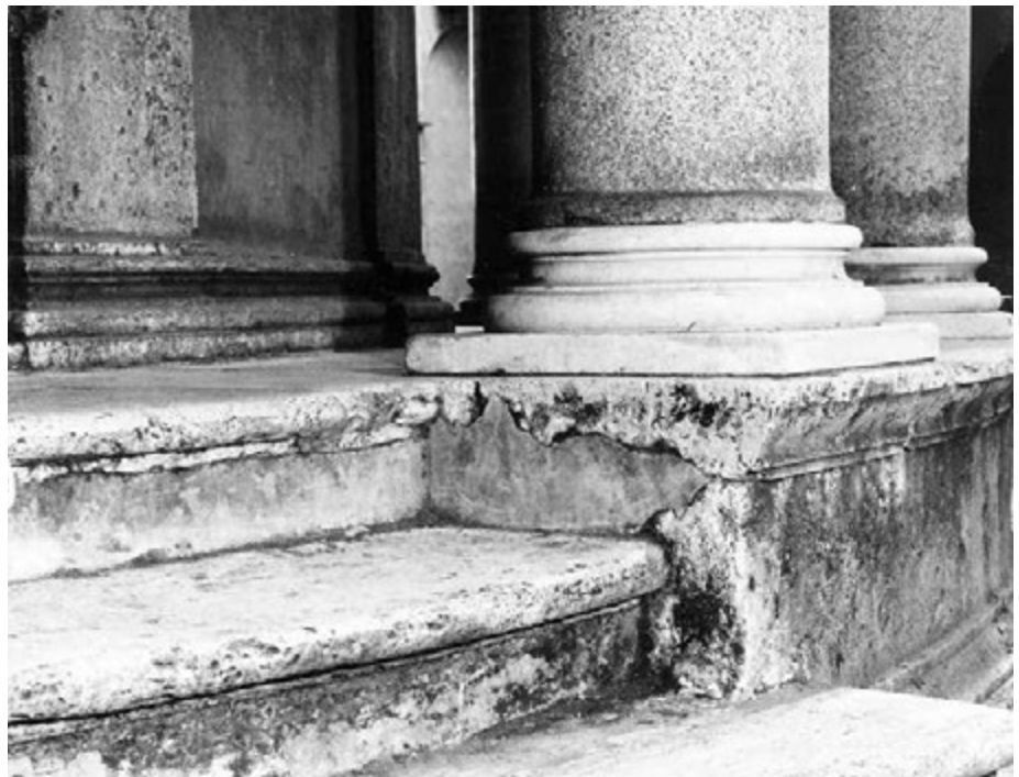
Fig. 5. Taglio dello stilobate per l'inserimento dei gradini di accesso agli ingressi laterali, eseguito in un secondo tempo (foto Bibliotheca Hertziana)
