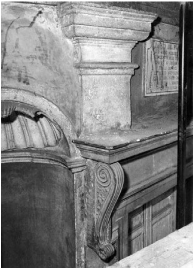
Fig. 6. Ingresso principale ad est. Sopra la parasta dorica è stata inserita successivamente la trabeazione marmorea ionica con mensole a voluta (foto Bibliotheca Hertziana)
