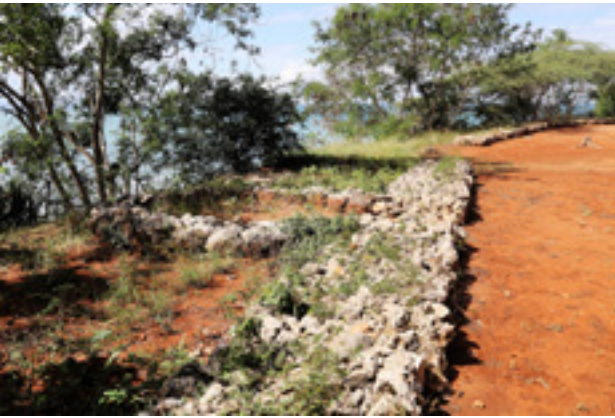
↑ Restos de la muralla con una estructura anexa
