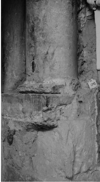
Imagen 3. Detalle del basamento de las columnas.
