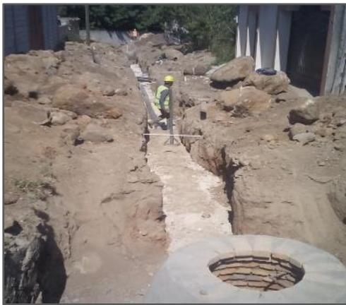
Fotografía 3: Imagen de las Obras de Construcción de las redes de alcantarillado en las colonias de Gracias, Lempira (2017).
