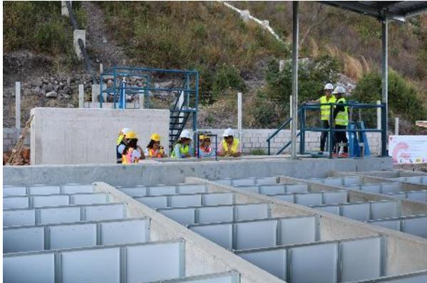
Fotografía 1: Vista de los floculadores de la Planta Potabilizadora ETAP Cabeza de Danto (2018).
