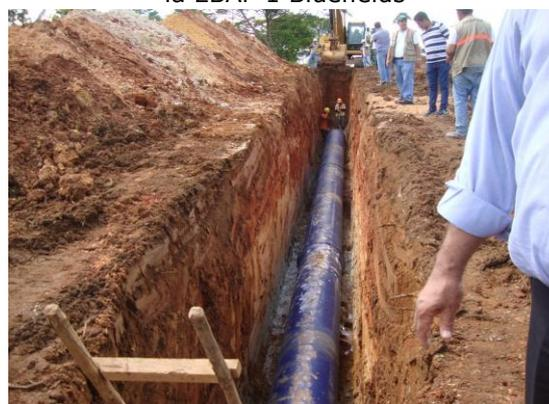
Fotografía 4: Colocación tubo 700 HFD sin entibado de la zanja en línea cond. Bluefields
