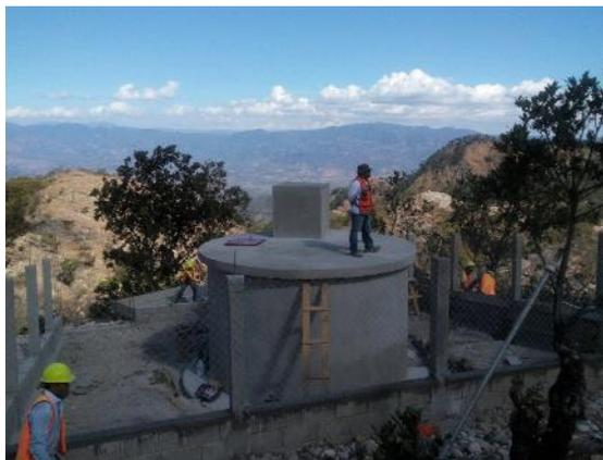
Fotografía 1: Obras de Construcción de la I Etapa del Sistema de Agua de Mercedes de Oriente (2017).
