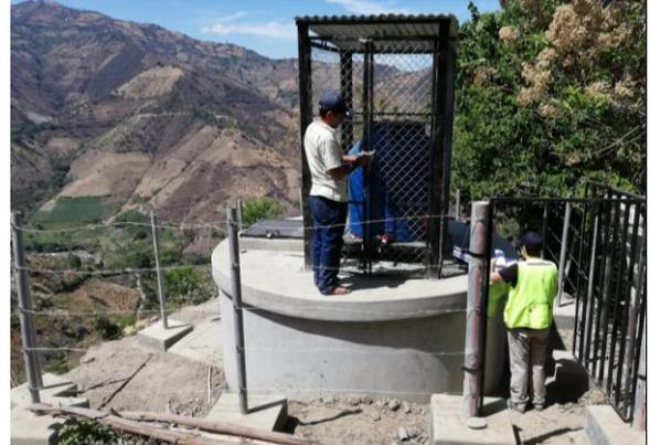
Fotografía 2: Reservorio y sistema de cloración del sistema de abastecimiento de agua potable de la Localidad de Canales-Sapillica
