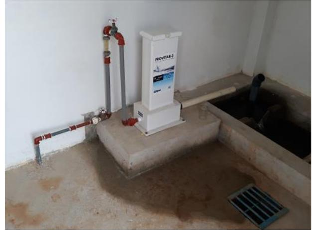
Fotografía 2: Sistema de cloración de la planta tratamiento Comunidad La Esperanza Municipio Balsas (Prov. Los Ríos)
