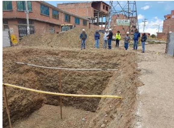
Fotografías 5,6 y 7. Alcantarillas profundas, cámaras de inspección profundas, paso de carretera camino Oruro.
