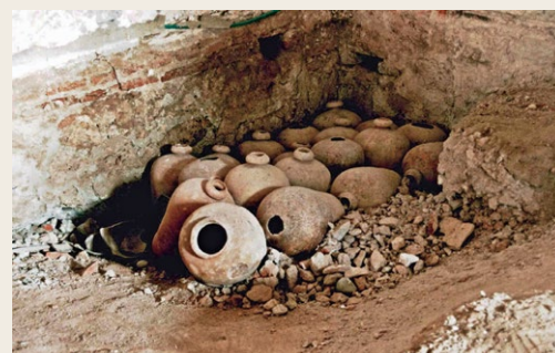
▲ Tinajas de relleno sobre bóvedas laterales de la iglesia de Santo Domingo. Fotografía: archivo OTC
