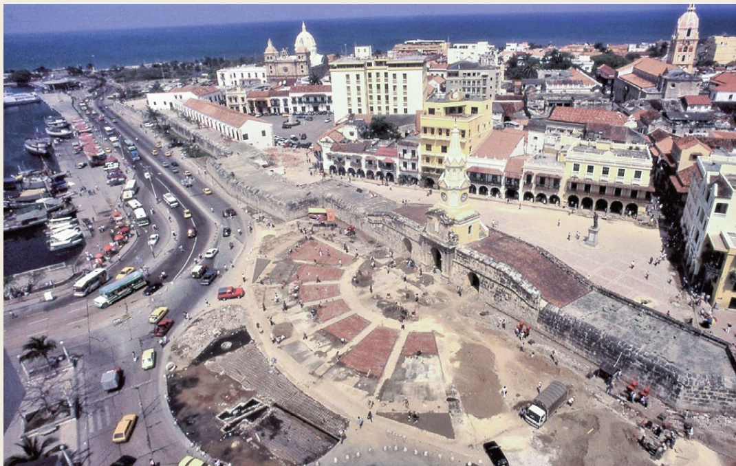
◀ Construcción de la nueva plaza de la Paz. Fotografía: LVC
