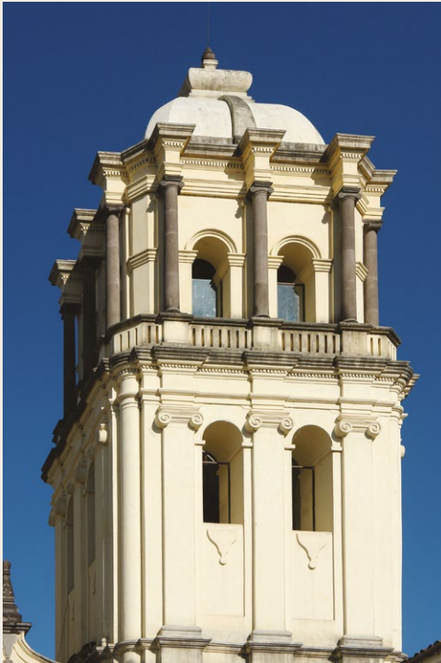
▲ Torre campanario después de la intervención. Fotografía: archivo OTC
