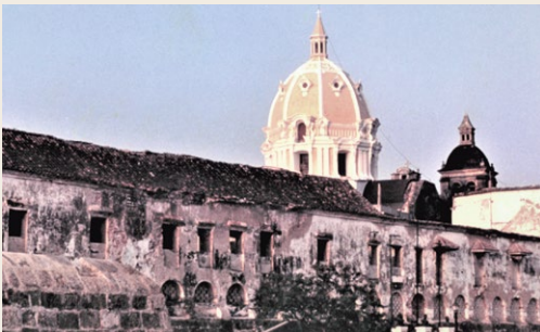
▲ Fachada del Museo Naval antes de la intervención. Fotografía: LVC
