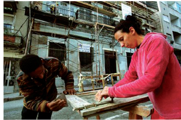
إعادة تأهيل الواجهات - المدرسة الورشة
