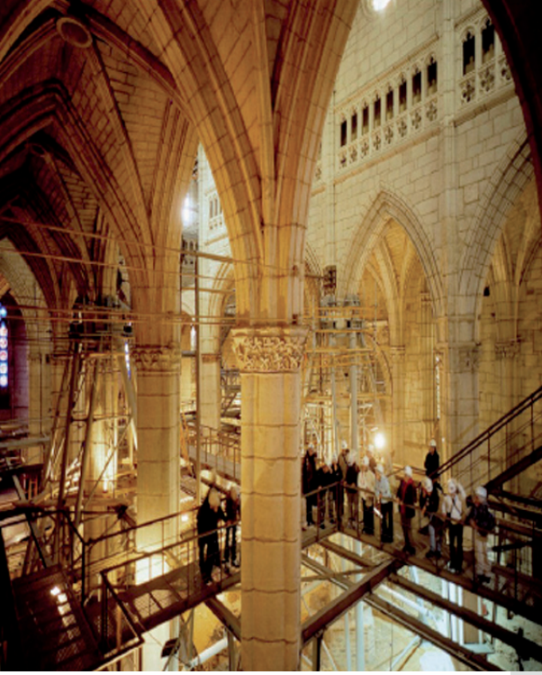
زيارة موجهة للكاتدرائية خلال أعمال ترميمها
