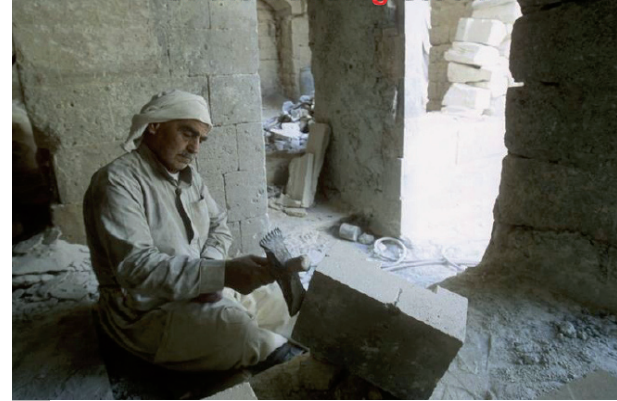
داخل بناية تم ترميمها ضمن المشروع خبراء حرفيون في عملية تدخل
