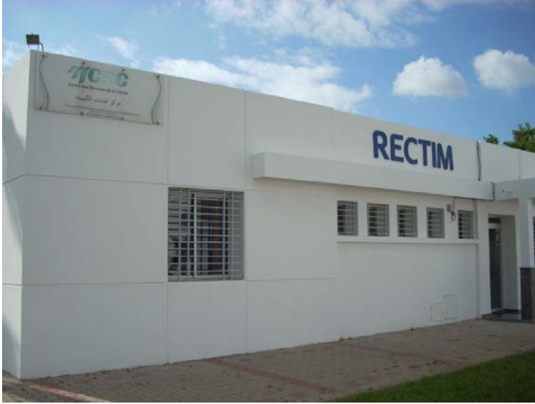
Instalaciones del RECTIM, en el edificio ocupado previamente por CSC
