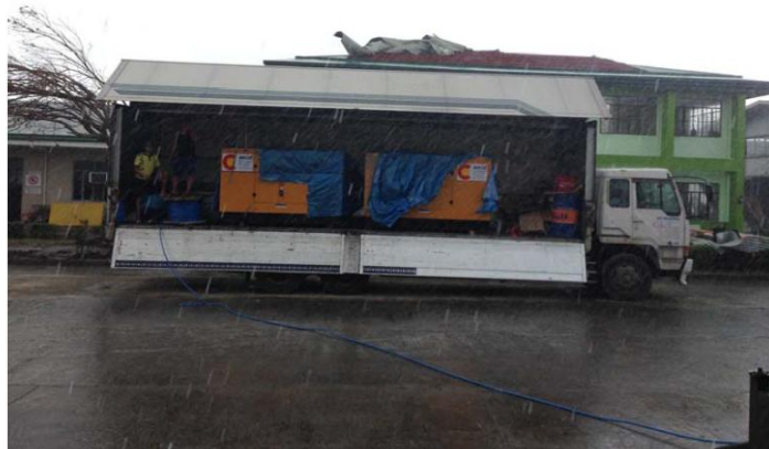
Generadores donados por la AECID
