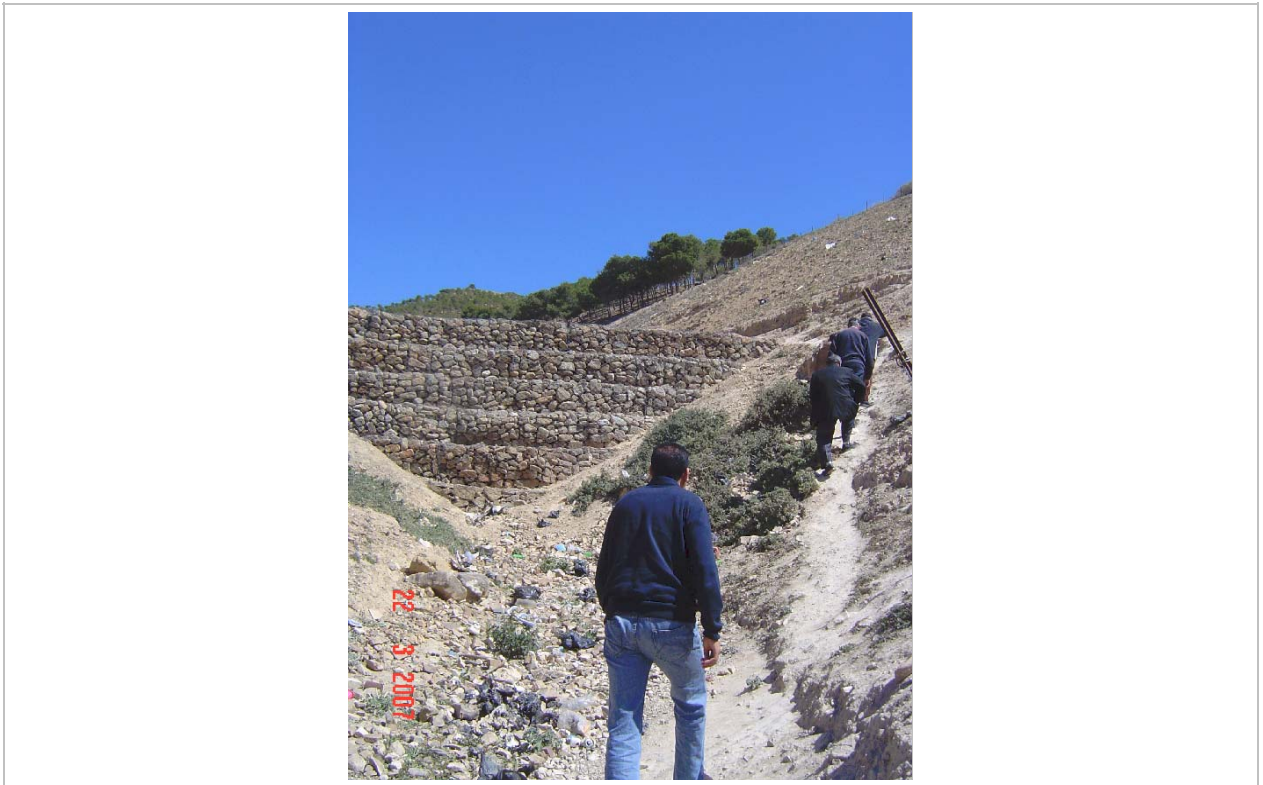
Figure 3.4 Gabions à Jebha
